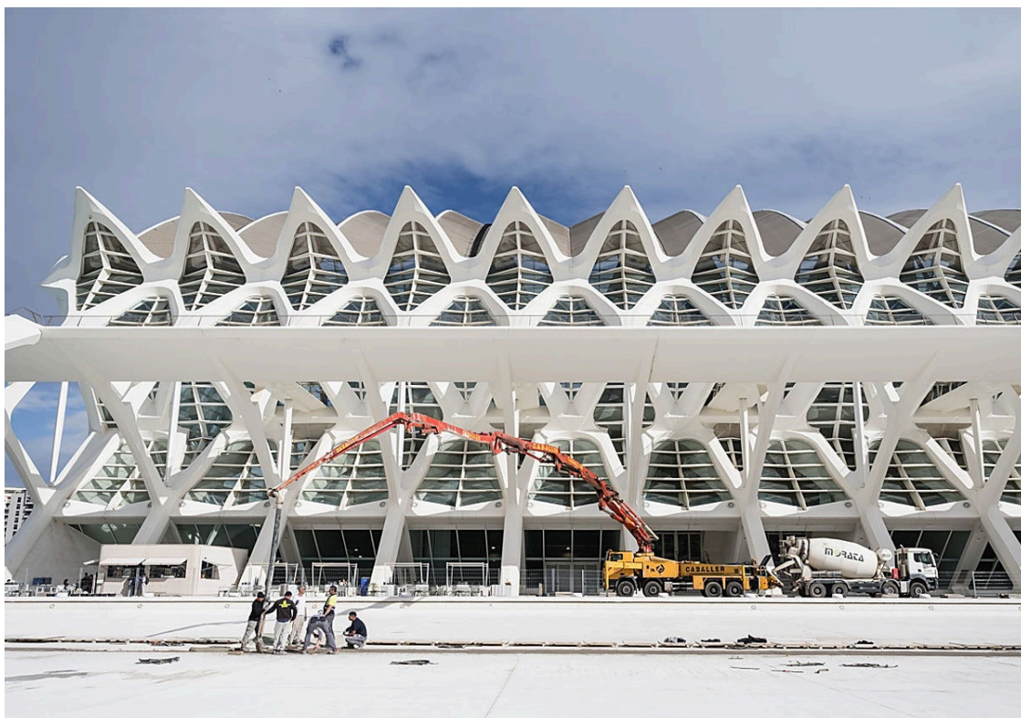
Imagen de las obras en los lagos de la Ciudad de las Artes y las Ciencias ABC
